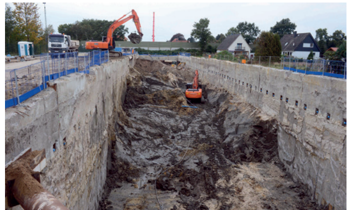
Im Baudock beginnt der Erdaushub im Schutz der verankerten Schlitzwände.
