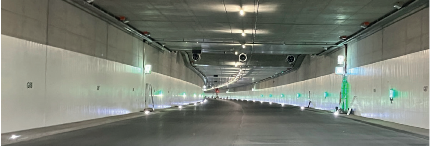
Einbau der Tunnelbeleuchtung sowie des komplexen Belüftungssystem
