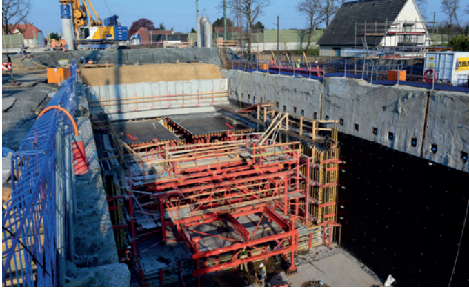
Schalwagen für die Betonierung der Tunnelsohle und Wände im Baudock 11
