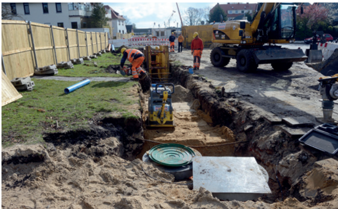
Vor dem eigentlichen Baubeginn des Tunnels mussten umfangreiche Vorbereitungen, wie z. B. die aufwendige Verlegung von Versorgungsleitungen im gesamten Baubereich getroffen werden.
