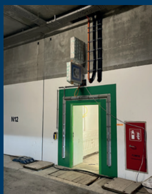
Zugang zu den Fluchttreppenhäusern im Tunnel
