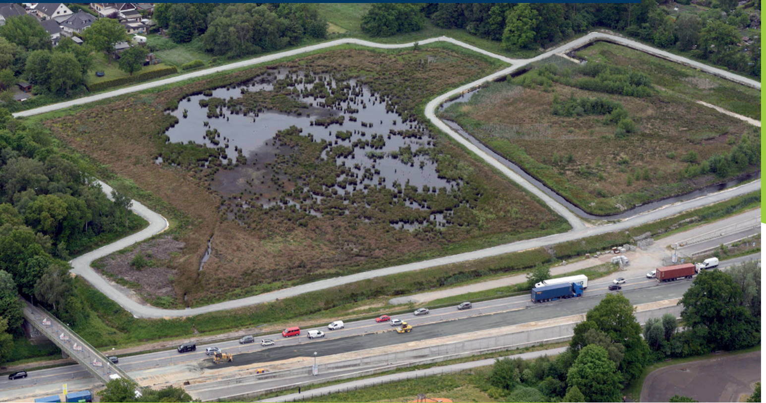
Wiedervernässung des bereits vor Baubeginn trockengelegten und bewaldeten Bredenmoors
