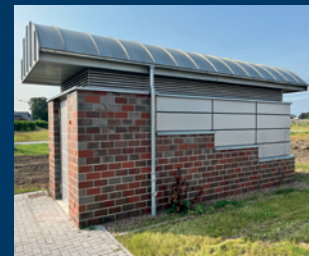
Ausgang von einem der zehn Fluchttreppenhäuser des Hafentunnels
