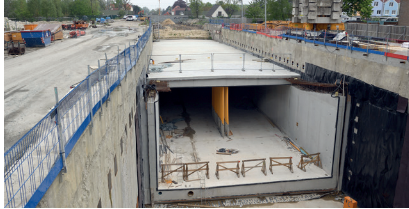
Der fertige Rohbau des Tunnelsegments Baudock 12. Beim dahinterliegenden Baudock 11 wird die Oberfläche mit Sand aufgefüllt.
