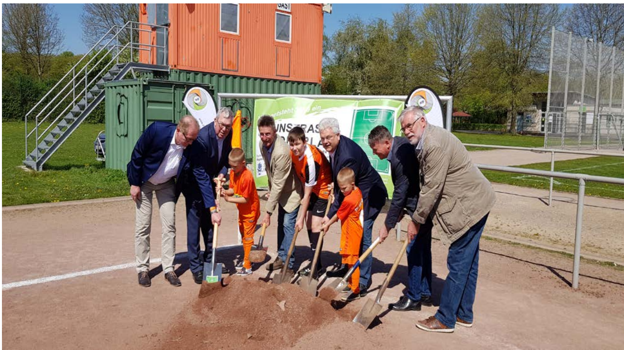
Foto: Erster Spatenstich für den Kunstrasen in Leherheide
